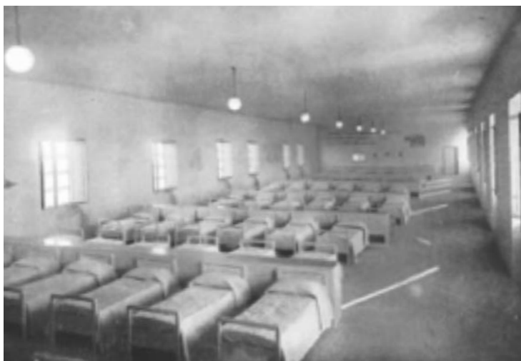
Borgo a Buggiano. Interno delle camerate della colonia "Carlo Galimberti".
