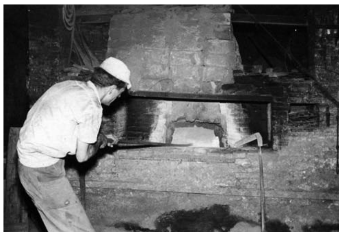
Operatore che poco prima della fusione toglie le scorie dal bronzo liquido.
